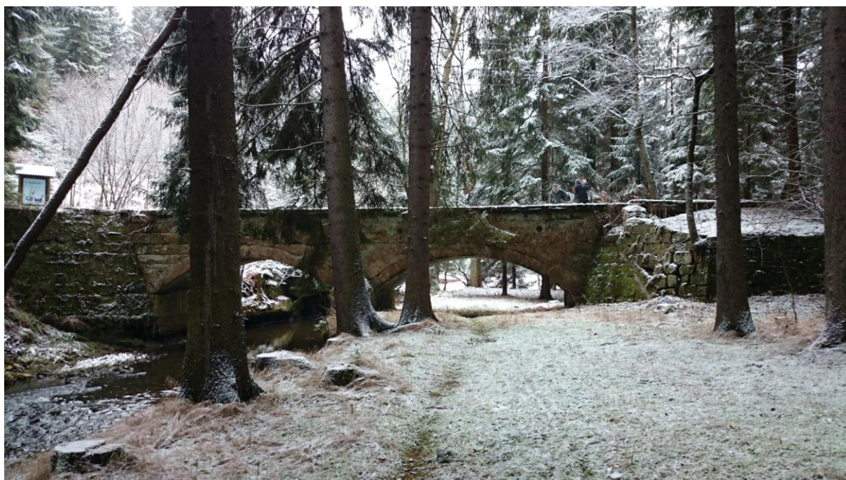
Obr. 13 Chřibská Kamenice, akvadukt náhonu pro Hübelovu tkalcovnu
