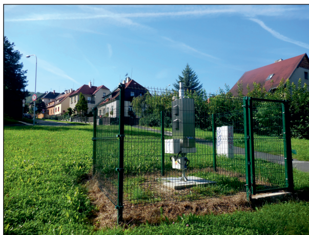
Obr. XI.6 Stanice MIM Karlovy Vary – vzorkovač suspendovaných částic PM_x ve venkovním ovzduší
